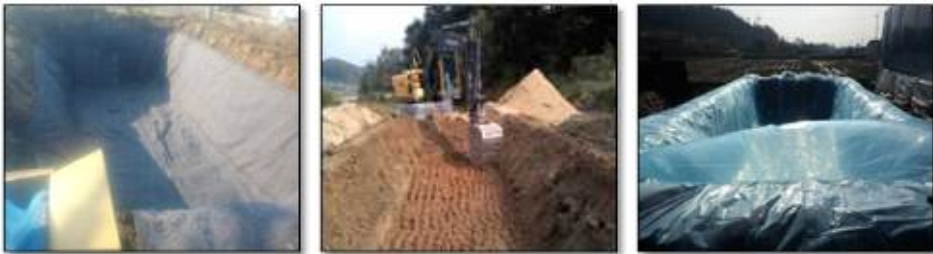
[그림 6] 부직포 깔기 [그림 5] 구덩이 파기 [그림 7] 차수비닐 깔기
